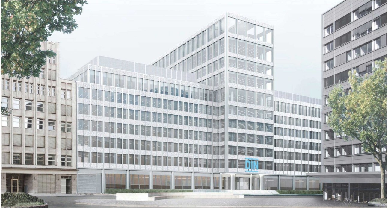
© Kim Nalleweg Architekten
